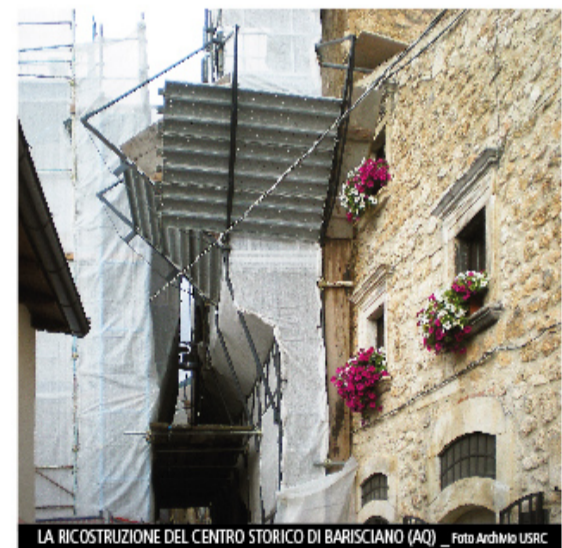
LA RICOSTRUZIONE DEL CENTRO STORICO DI BARISCIANO (AQ) _ Foto ArchMio USRC
