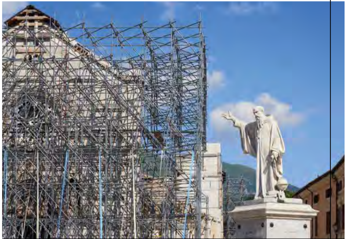
2016-2017, SISMA DEL CENTRO ITALIA. IL PUNTELLAMENTO DELL BASILICA DI SAN BENEDETTO A NORCIA _ Foto di Roma Oslo/Stock, Getty Images
