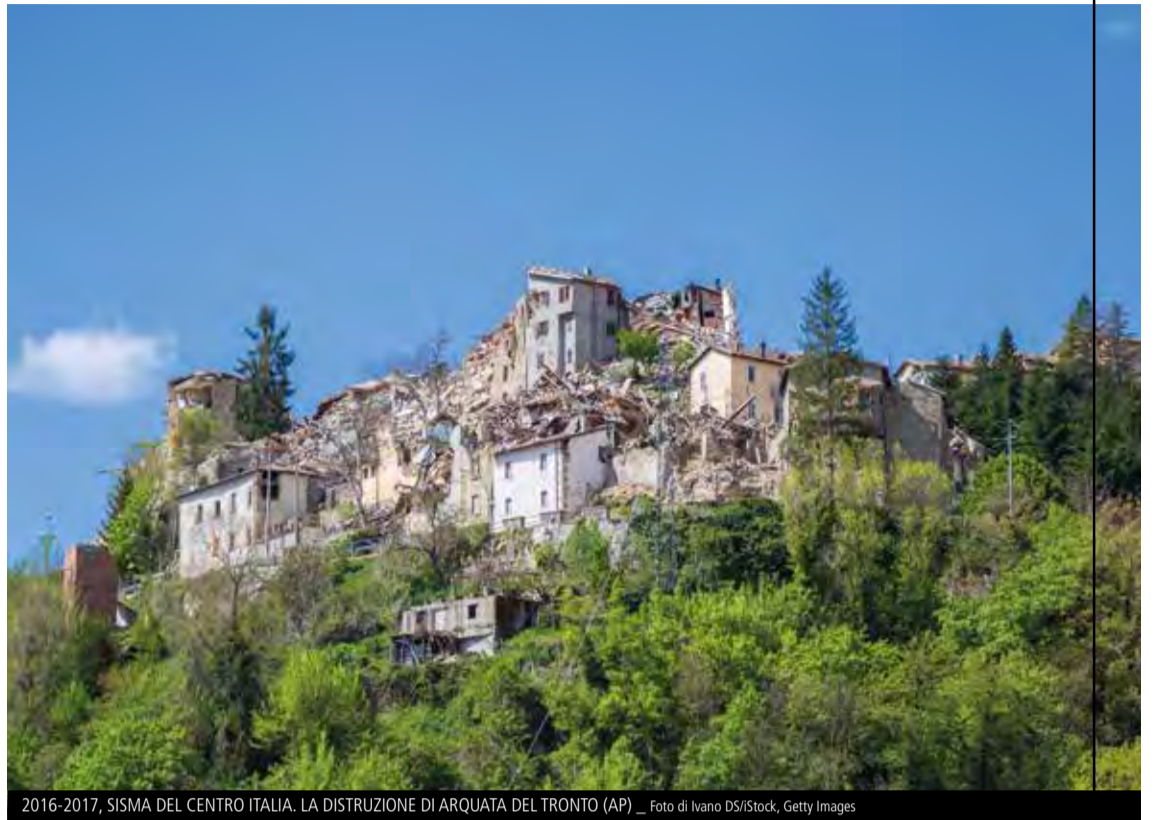
2016-2017, SISMA DEL CENTRO ITALIA. LA DISTRUZIONE DI ARQUATA DEL TRONTO (AP) _ Foto di Ivano DS/Stock, Getty Images
