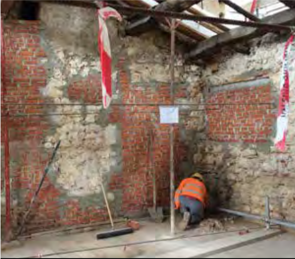
RECUPERO E RISARCIMENTO DI MURATURA CON LA TECNICA DEL CUCI E SCUCI Foto Archivio Impresa Frezza A. e P. spa
