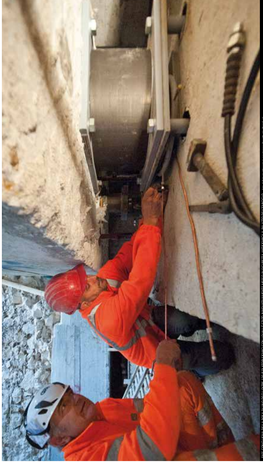
FASE CONCLUSIVA DELLA POSA DI UNO DEGLI ULTIME 130 SOLAIOBIBBICI CON I QUAVI È STATO INNOVATIVAMENTE MESSO IN SICUREZZA ANTISISMICA IL PALAZZO DELL'EMICICLO. Foto di Roberto Morabito per Impresa Bco W. srl e Ricci G. srl
