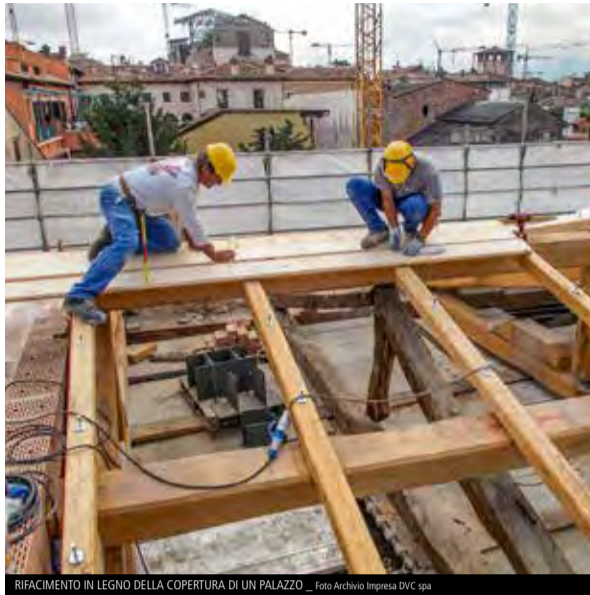
RIFACIMENTO IN LEGNO DELLA COPERTURA DI UN PALAZZO _ Foto Archivio Impresa DVC spa
