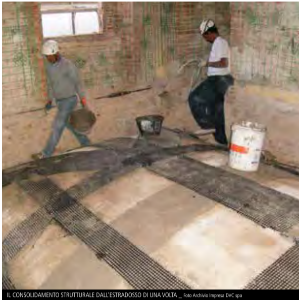
IL CONSOLIDAMENTO STRUTTURALE DALL'ESTRADOSSO DI UNA VOLTA _ Foto Archivio Impresa DVC spa
