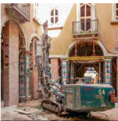
IL COMPLESSO INTERVENTO DI CONSOLIDAMENTO FONDALE E DEI PILASTRI DEL CORTILE PORTICATO DI PALAZZO CAPPA CAPPELLI _ Foto Archivio Impresa OVC & Strever
