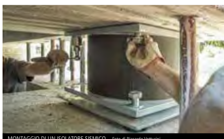
MONTAGGIO DI UN ISOLATORE SISMICO - Foto di Riccardo Vetturini
