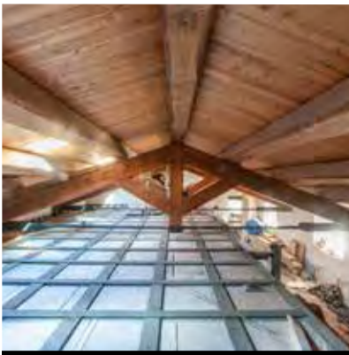
CATENE E TETTO ALLEGGERITO IN LEGNO MIGLIORANO NETTAMENTE LA CAPACITÀ ANTISISMICA DELLE COPERTURE DEGLI ANTICHI PALAZZI DEL CENTRO STORICO Foto Archivio Impresa Frezza A. e P. spa
