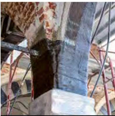
INTERVENTO DI CONSOLIDAMENTO CON FIBRE DI CARBONIO DEL COLONNATO DEL CONVENTO DI SAN DOMENICO _ Foto di Maurizio D'Antonio
