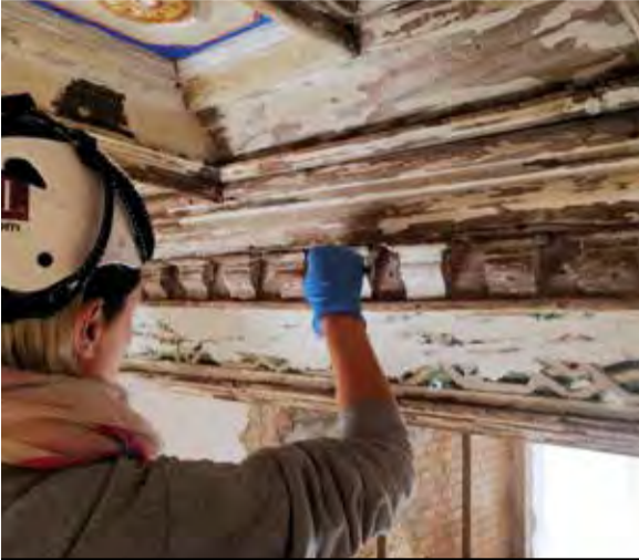
IL RESTAURO MATERICO E PITTORICO DI UN CASSETTONATO LIGNEO POLICROMO Foto Archivio Impresa Gavioli Restauri srl
